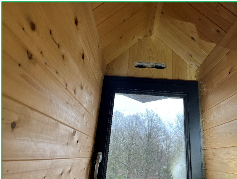
Ruimte in het nieuwe dak voor de opvang van vleermuizen
