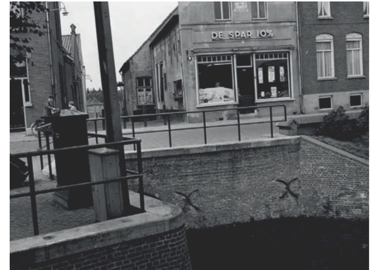
Het sluisje bleef eeuwenlang van groot belang en werd verschillende malen gemoderniseerd. In de achttiende eeuw werd een stenen sluis gebouwd die tot ca 1970 zijn functie zou behouden. De sluis bevond zich onder de zogenaamde sluisgang tussen de Kade en de achterliggende straat het West-Vaardeke.
