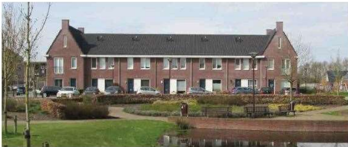
Eigentijds dorps architectuurstijl met een eenvoudige en heldere hoofdvorm, verbijzondering hoeken en een uitvoering in donker roodbruin metselwerk met antracieten kap
